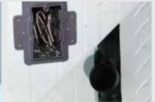
Instalar el sistema eléctrico, tuberías y cubierta
