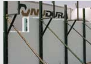
Alinear la pared para el vertido de hormigón
