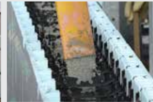
Verter el hormigón dentro de las paredes
