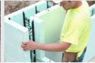
Apilar los módulos y crear aberturas
