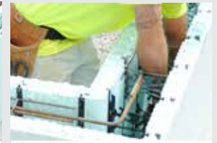
Colocar las varillas en las paredes
